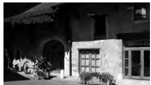
Maison du Charron, 6 rue des Moulins, 1290 Versoix
