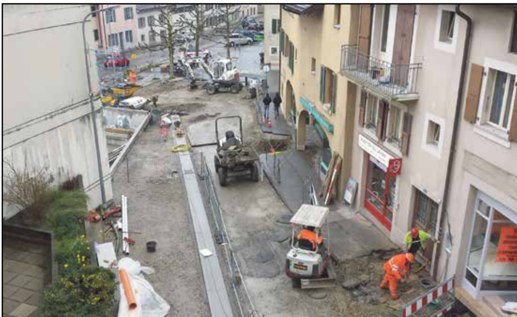
Les travaux de la rampe de la gare touchent à leur fin. Le goudron sera posé prochainement.
