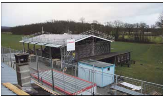
Le bâtiment de la chaufferie à bois avec les panneaux solaires.
