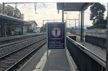
La longueur des quais 2 et 3 a été rétrécie, car le virage ne respecte pas les normes légales pour l'accès aux personnes à mobilité réduite.
