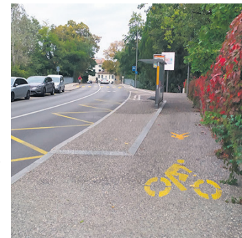
Arrêt Versoix La Scie - 10.10.2021 Bordures "tremplin" dangereuses (Joël Comminot)
