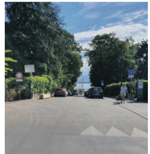
Après les travaux de réaménagement réalisés sur les chemins des Graviers et Huber-Saladin.
