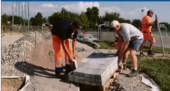
Les travaux préparatoires du fitness ont été réalisés par le service de la Voirie et des jeunes embauchés pendant l'été.
