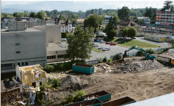
Les travaux vont durer entre deux et trois ans.
