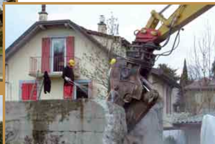
Démolition du fortin militaire en rive gauche.
