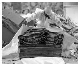
DÉPOSE DE FIBROCIMENT
