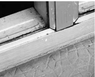
JOINTS ENTRE CADRE ET MUR
