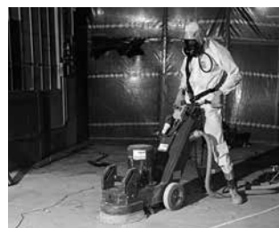
PONÇAGE MÉCANIQUE
