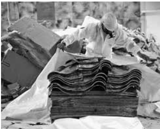
DÉPOSE DE FIBROCIMENT
