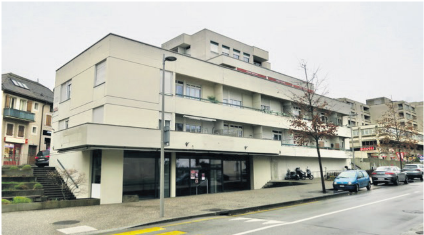
Les locaux convoités le long de la Route de Suisse
