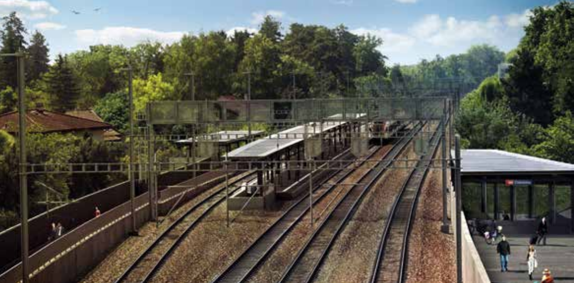
Future gare de Chambésy.
